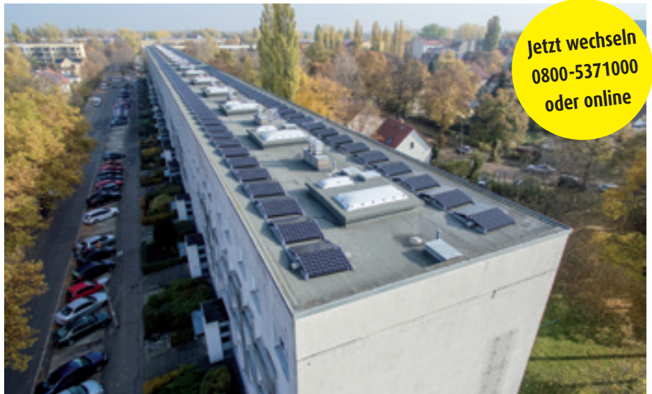
Foto: Stadtwerke, Solaranlage Rolandstraße, © Reiner Freese
