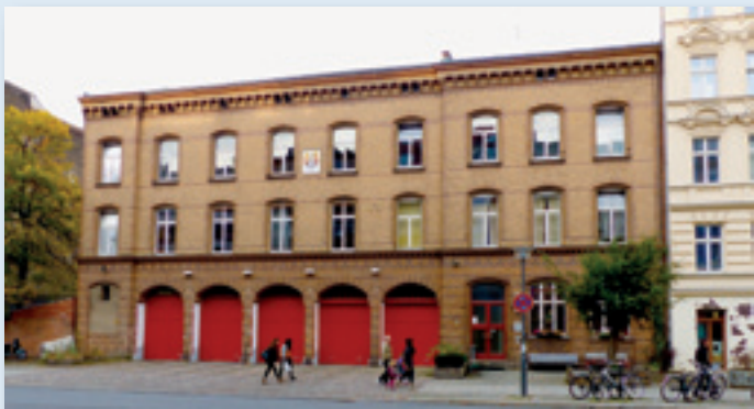
Die Feuerwache Prenzlauer Berg in der Oderberger Straße 24 ist die älteste noch im Dienst befindliche Berufsfeuerwehr in Deutschland.
